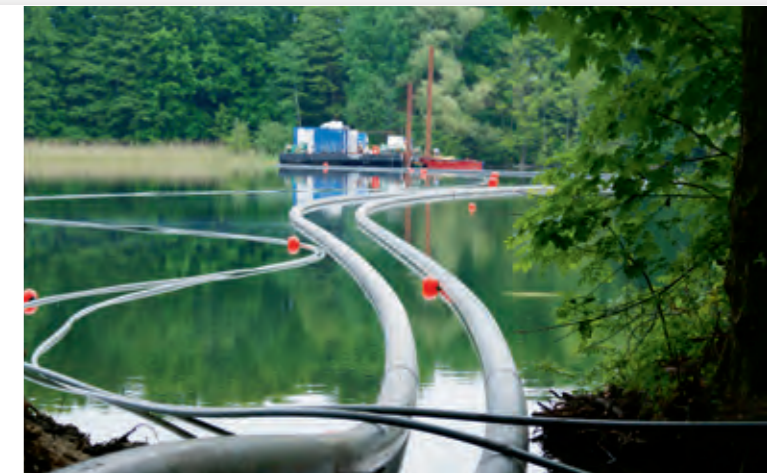
Verlegung des 20kV-Seekabels mitten durch den Neumühler See
