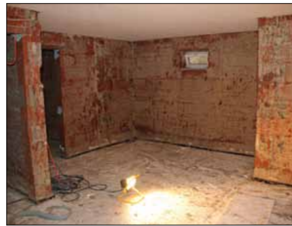
Der Keller stand bis unter die Decken unter Wasser und musste entfeuchtet werden Foto: privat
