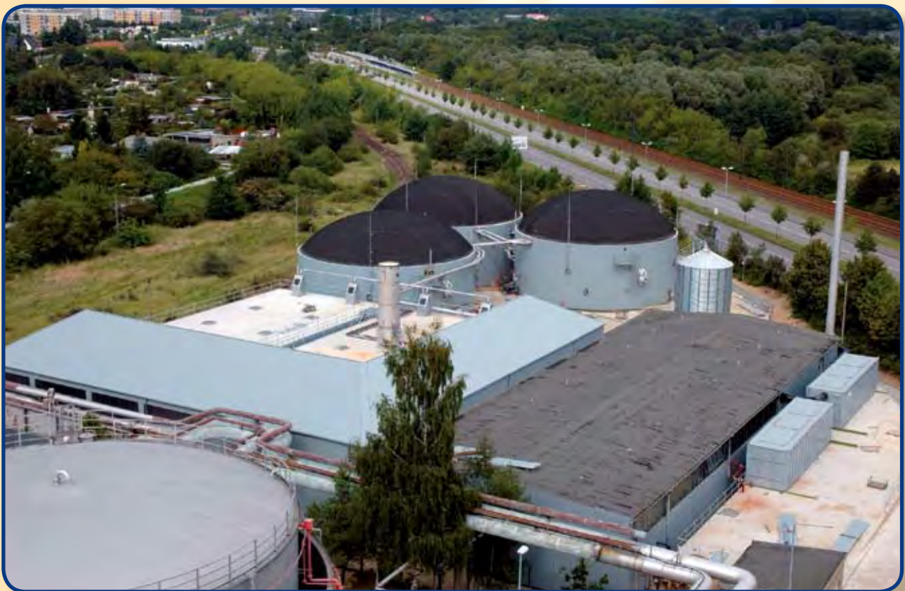
Die Biogasanlage in Schwerin-Süd.
