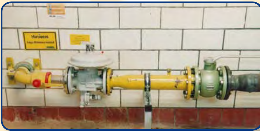
Hausanschluss Erdgas.
