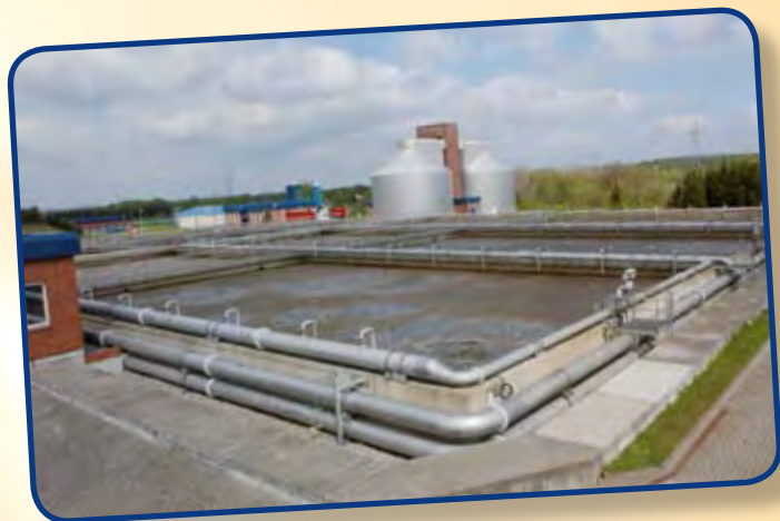
Die Kläranlage in Schwerin-Süd.
