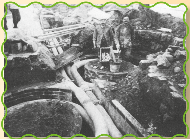
Alte Fernwärmeleitungen in der August-Bebel-Straße.
