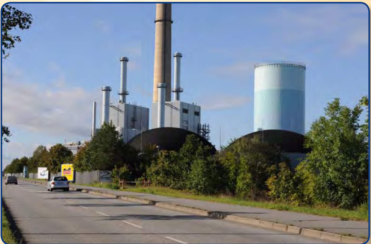
Heizkraftwerk mit Wärmespeicher und Biogasanlage.
